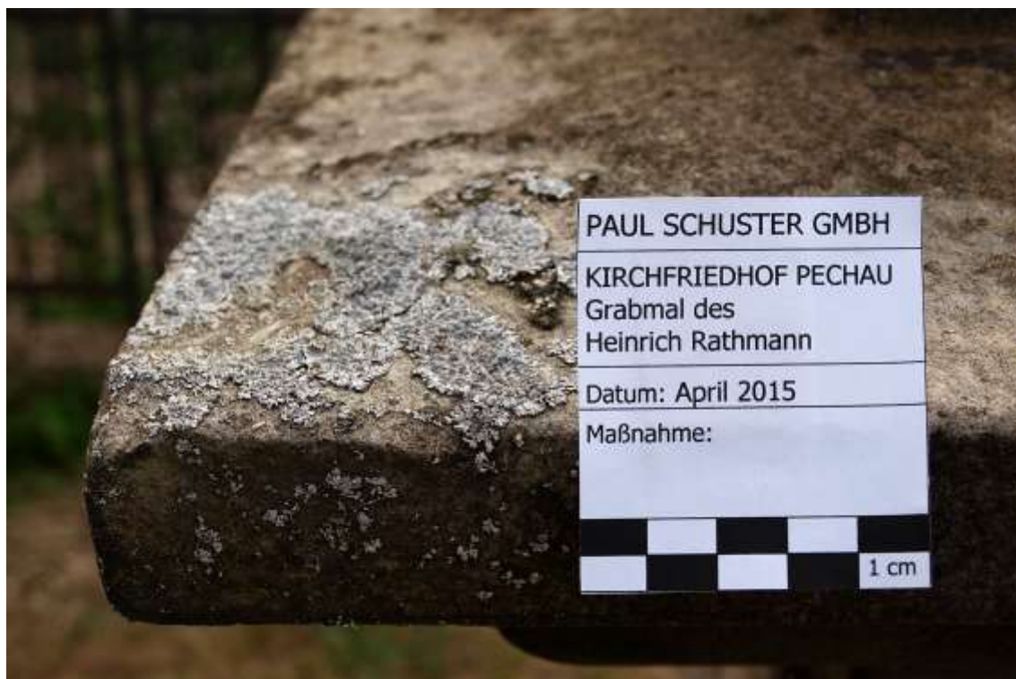
Abb. 7: Biogener Bewuchs durch Flechten (Abdeckplatte, Westseite)
