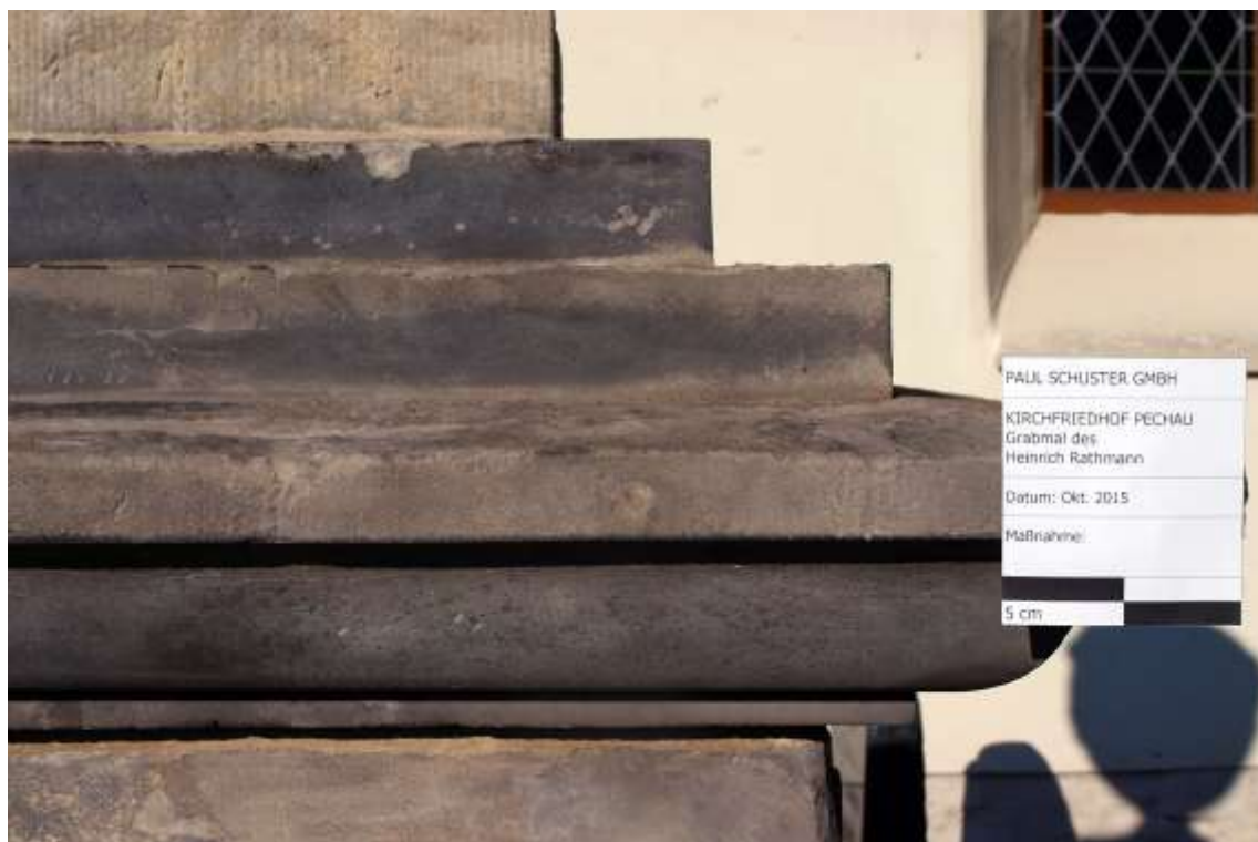
Abb. 16: Vernadelter Bereich der Abdeckplatte nach Rissschließung und Retusche (Südseite)
