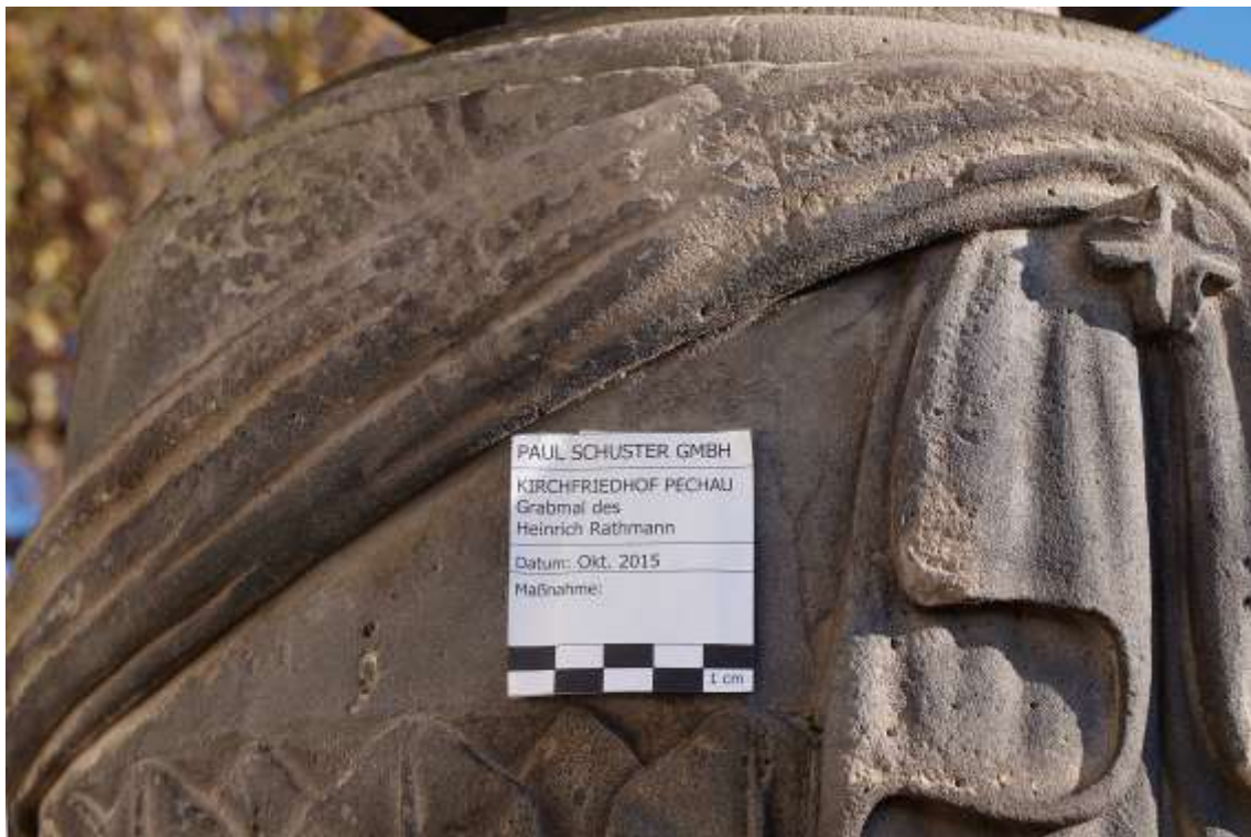
Abb. 19: Risskittungen nach Oberflächenbearbeitung und Retusche (Urne)
