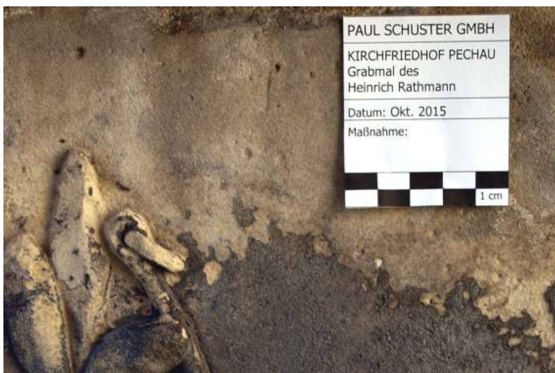
Abb. 10: Steinoberfläche nach Reduzierung der Gipskruste (Schriftfeld, Ostseite)
