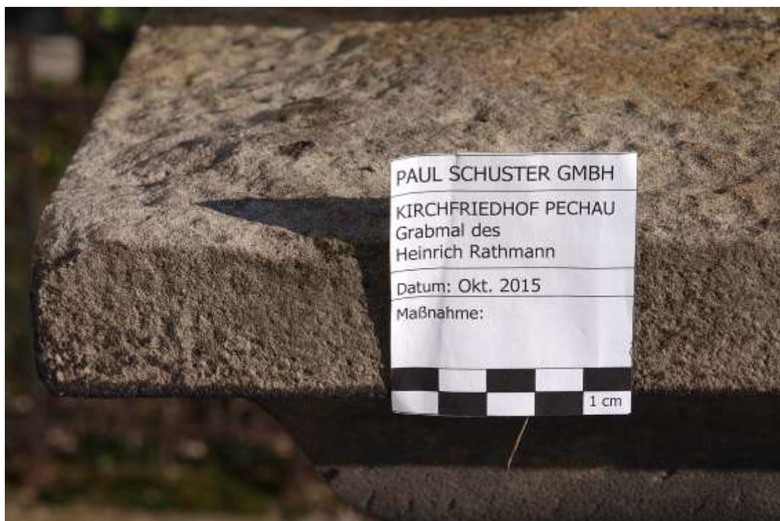
Abb. 8: Steinoberfläche nach Entfernung der Flechten (Abdeckplatte, Westseite)
