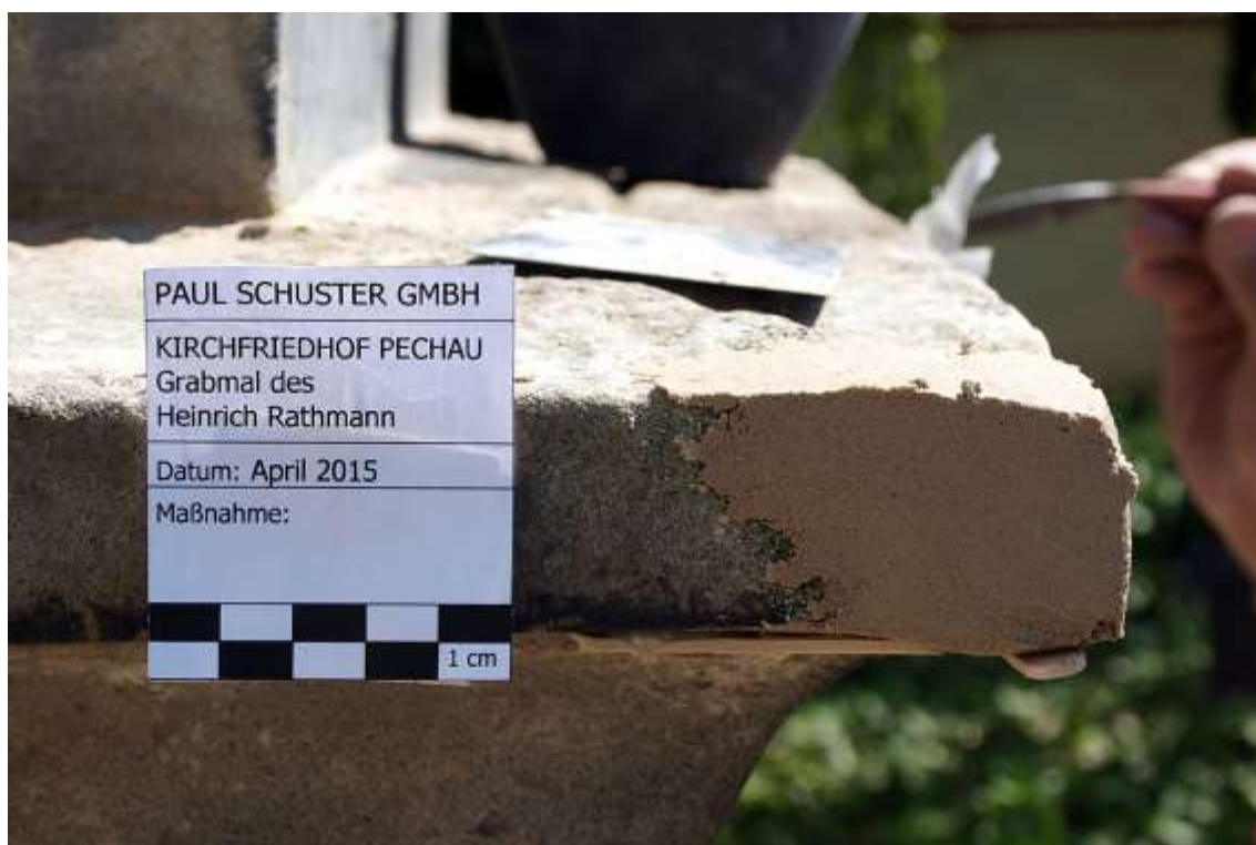
Abb. 33: Fehlstellenergänzung vor der Nachbearbeitung und Retusche (Abdeckplatte)
