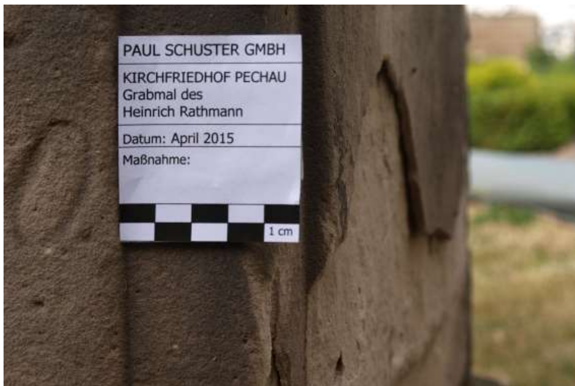
Abb. 25: Fehlstelle durch Schalenverlust (Schriftfeld, Nordseite)
