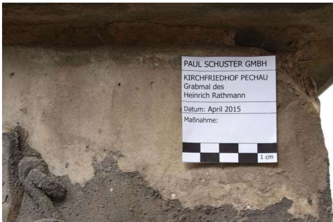
Abb. 27: Fehlstelle im Kantenbereich (Schriftfeld, Ostseite)
