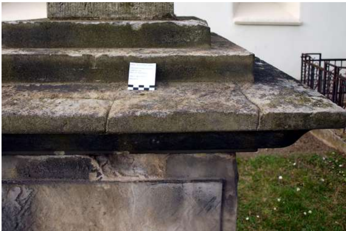
Abb. 14: Risse in der Abdeckplatte (Südseite)
