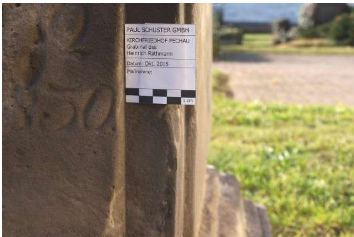
Abb. 26: Fehlstellenergänzung (Schriftfeld, Nordseite)
