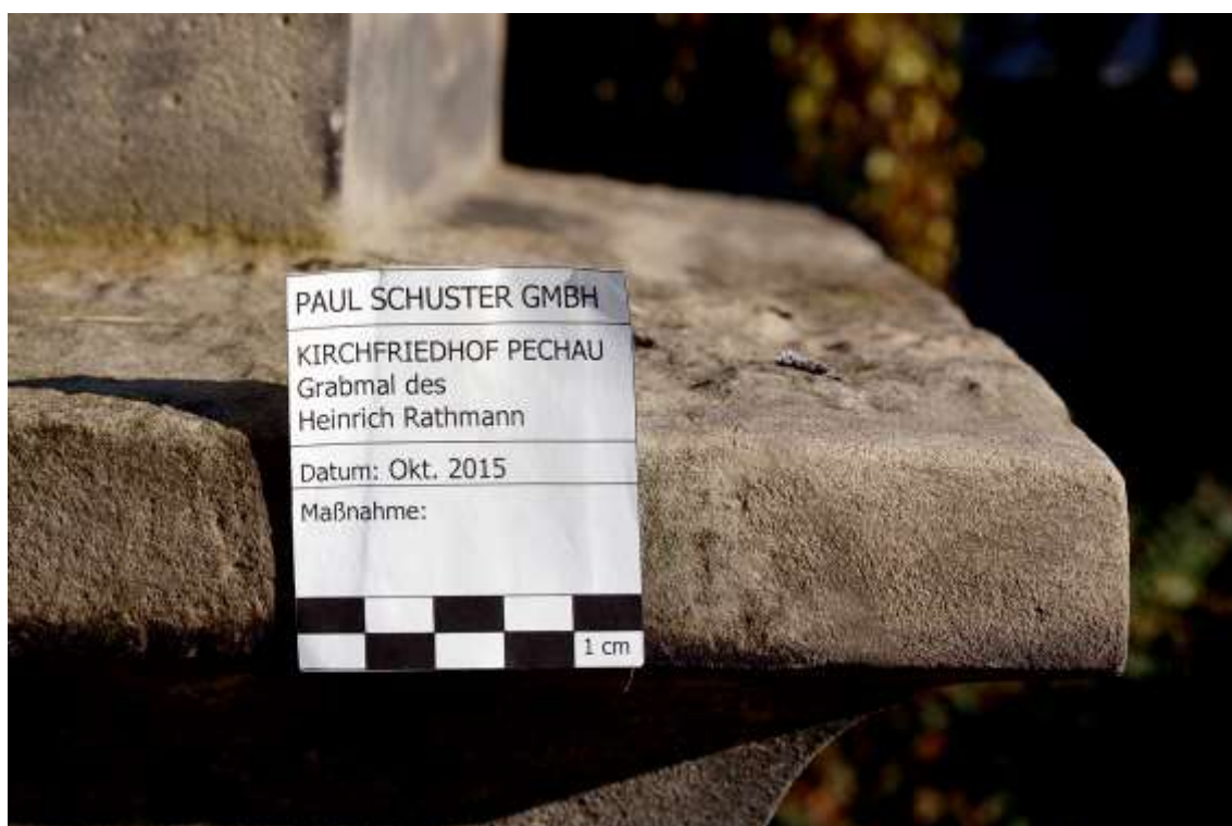
Abb. 34: Fehlstellenergänzung nach der Nachbearbeitung und Retusche (Abdeckplatte)
