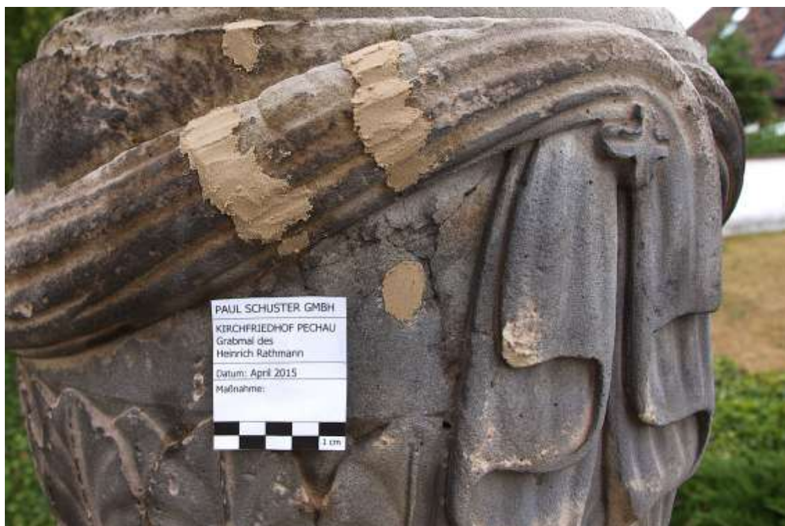
Abb. 18: Risskittungen mit mineralischem Ergänzungsmörtel (Urne)
