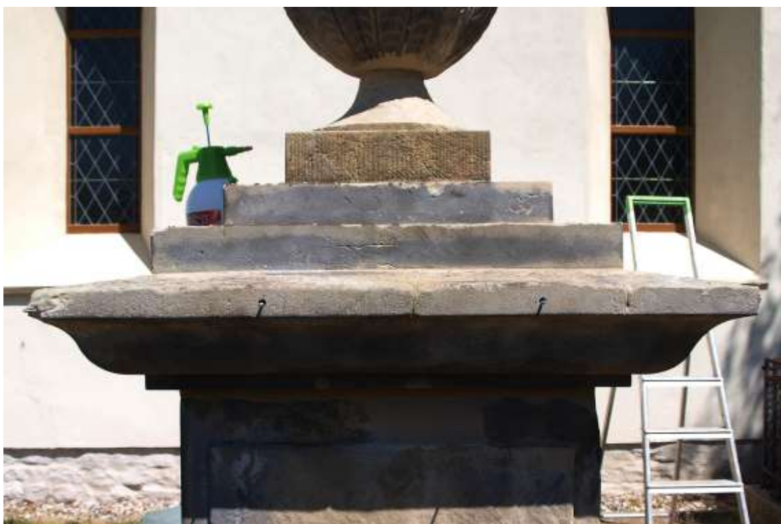
Abb. 15: Vernadelung sich lösender Gesteinsfragmente
