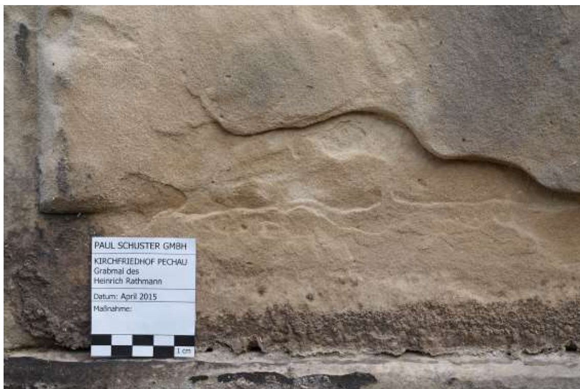
Abb. 12: Schalenbildung und Abschalen der Steinoberfläche (Schriftfeld, Südseite)
