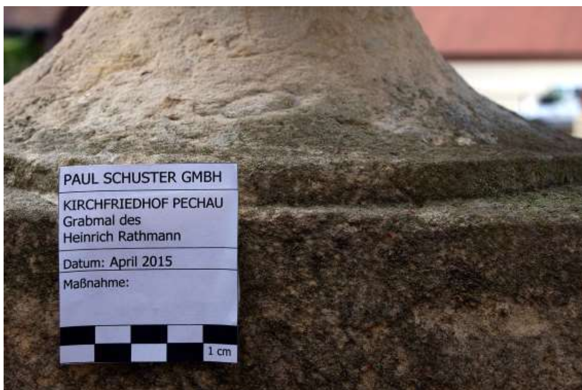
Abb. 22: selektives Auswittern fossiler Einschlüsse (Urnenfuß, Nordseite)
