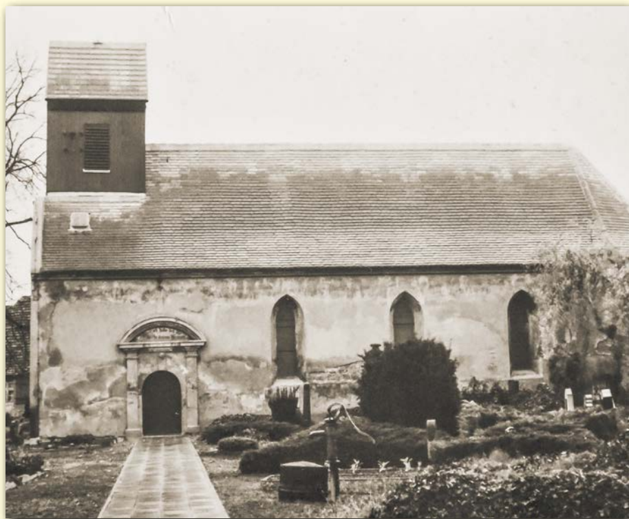
St. Thomas in Pechau, Aufnahme mit einfachem Holzturm, nachdem der zweistöckige Glockenturm aus Fachwerk 1984 abgetragen wurde
